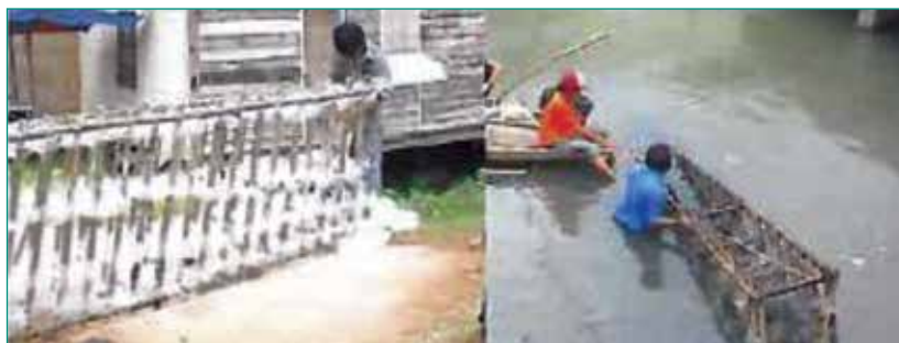
Figura 4: Esta imagen muestra la instalación de las jaulas con medio de cultivo biológico en el río.
