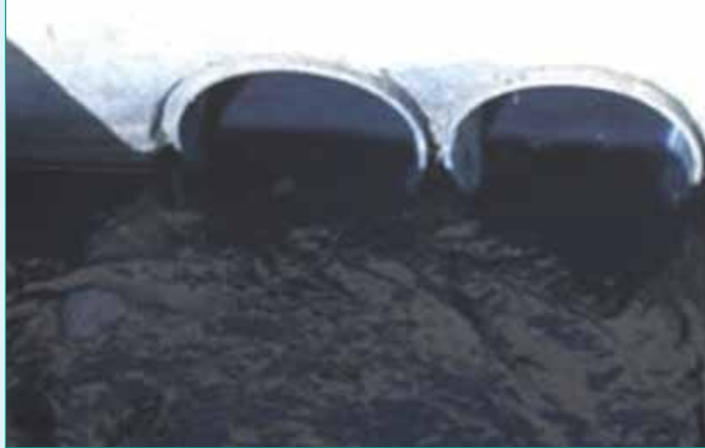
Figura 2: El efluente de la planta muestra niveles extremos del pigmento índigo en el agua residual.
