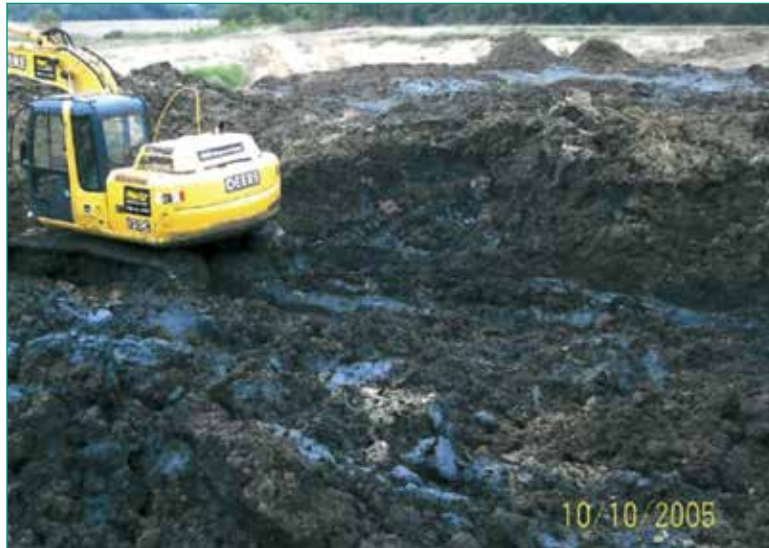
Figura 2: : Excavación para preparar la tierra de cultivo que muestra la extensión de la contaminación.
