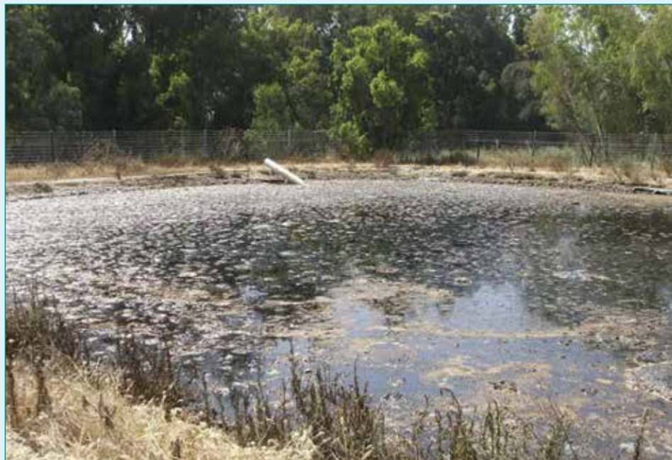
Figura 2: Primer plano de la laguna muestra la capa de aceite y suciedad en la superficie de la laguna.
