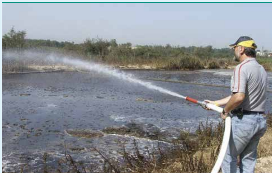
Figura3: El tratamiento se mezcló con agua y se roció sobre la superficie de la laguna para ofrecer el mayor contacto con el petróleo superficial.
