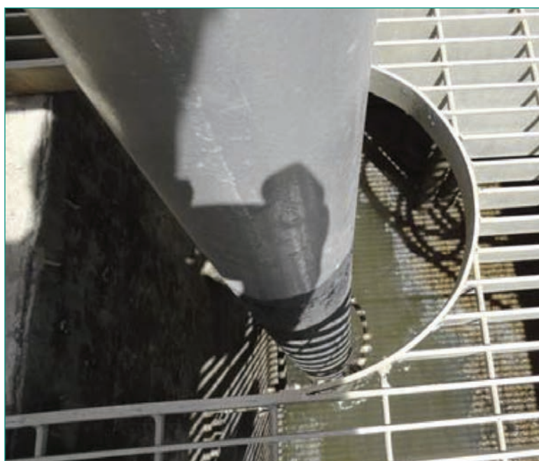
Figuras 5 y 6: Estas imágenes muestran la falta de acumulación de grasa nueva, desde una vista lateral y superior a través de la rejilla.
