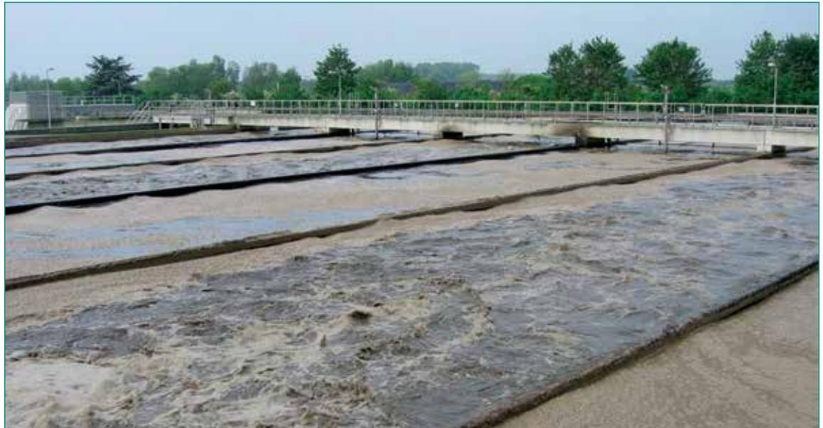
**Figura 1:** Esta imagen muestra las piletas de aireadas en paralelo. Debido a que estos canales tienen líneas de reciclaje segregadas, se pueden tratar por separado y el lodo residual de cada canal se puede evaluar y comparar.
