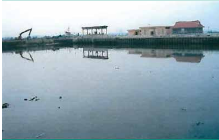
Figura3: Imágenes adicionales de la laguna y el sistema de drenaje.
