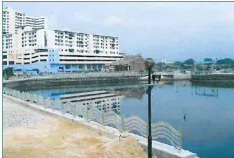
Figura 1: Imagen de la laguna de retención para la mitigación de inundaciones en Penang.
