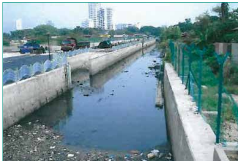
Figura 2: Imágenes adicionales de la laguna y el sistema de drenaje.
