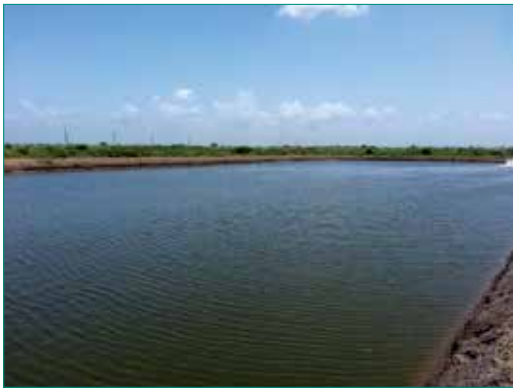
Estanque de Prueba
