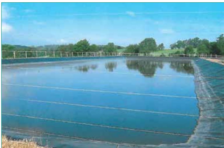
Figura 3: La segunda laguna quedó completamente limpia sin sólidos después del tratamiento de seis semanas en las fosas.
